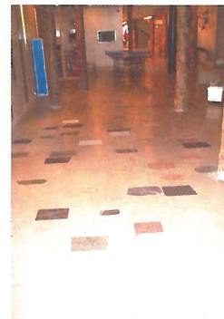
Een deel van de vloer in de gemeenschappelijke zone is gemaakt uit stenen uit de omgeving. In het gebouw zijn ook drie boomstammen te vinden.
